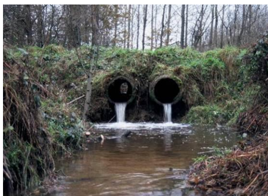
Figure 61 : Calage des buses pour la franchissabilité pour les poissons
