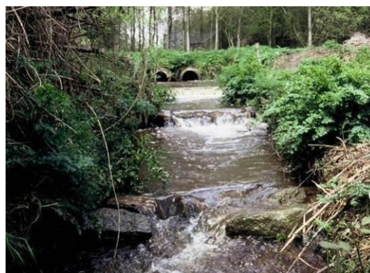
Figure 61 : Calage des buses pour la franchissabilité pour les poissons
