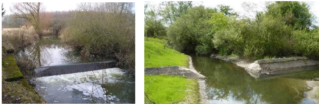
Figure 55 : Effacement d'obstacles sur le Mutterbach à Puttelange-aux-Lacs (57) On notera que l'obstacle est supprimé même si une partie de l'ouvrage reste en place – photos Agence de l'eau
