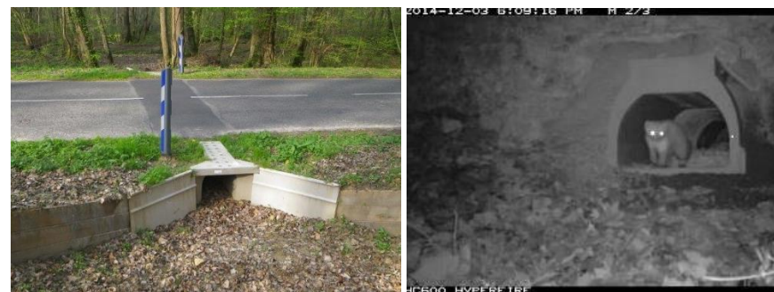
Figure 36 : Exemple de passages à petite faune (Source : © BIOTOPE, 2016)
